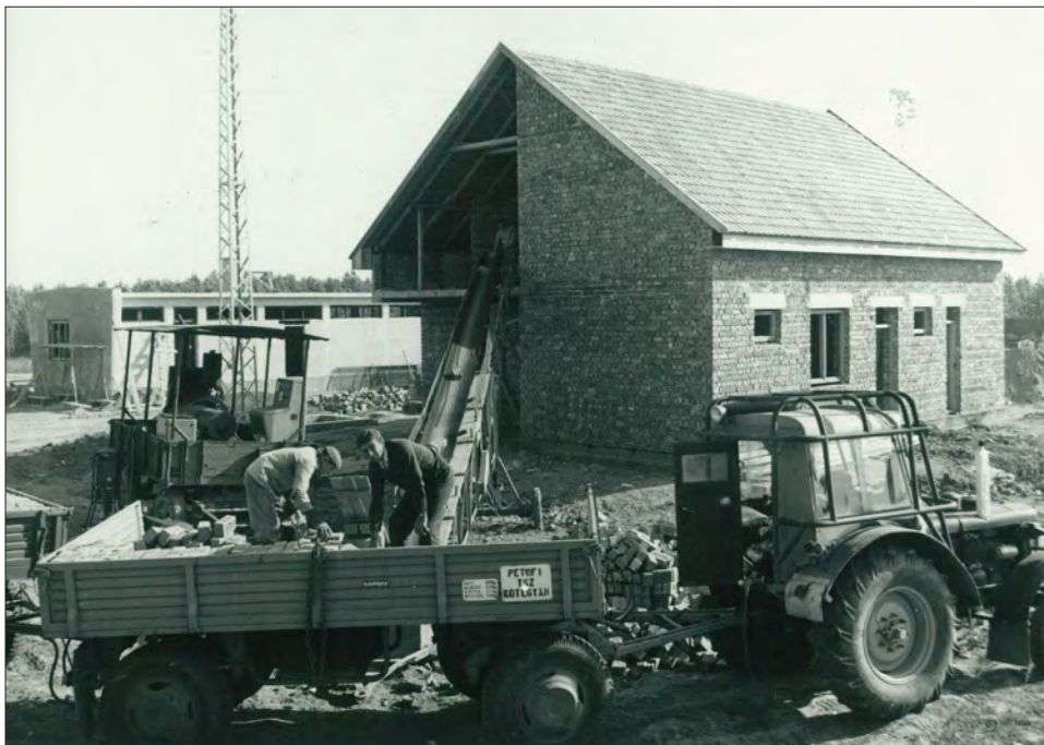
Az erdőmenti gátörtelep építése, 1977.
