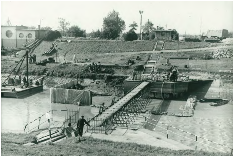
Fehér-Körös fix fenékgát építése, 1977.
