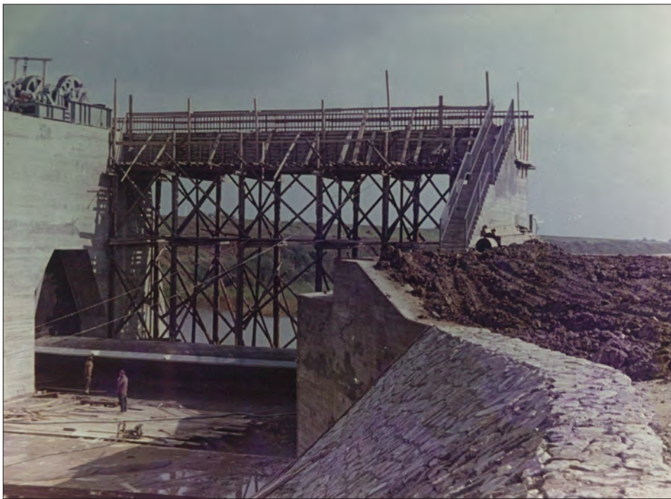
A Békési duzzasztó építése, 1967.
