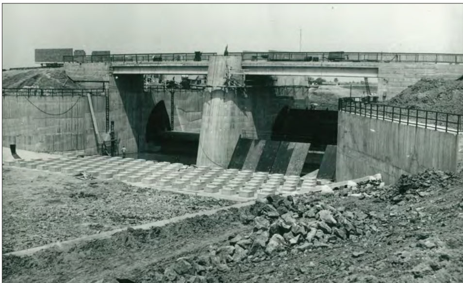
A Körösladányi duzzasztó építése, 1977.
