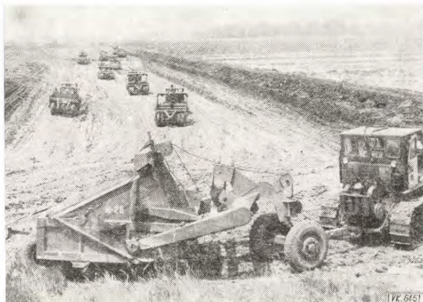
3. ábra. A dénesmajori körtöltés építése az 1974. évi árvíz idején
