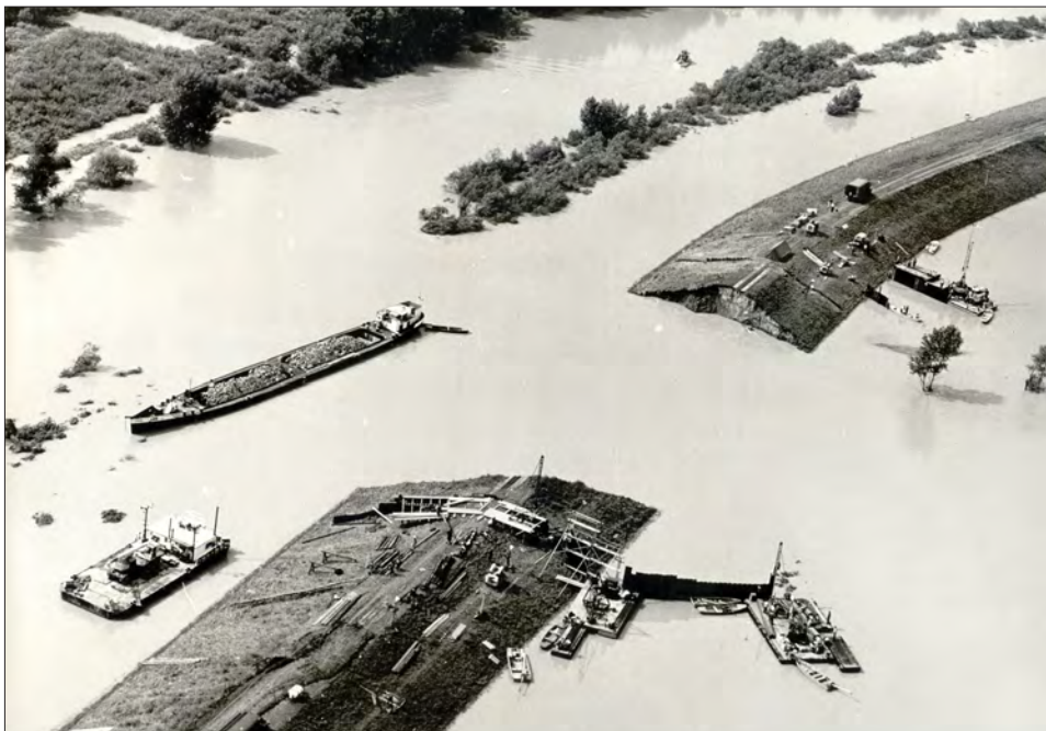
A hosszúfoki töltésszakadás, 1980.
