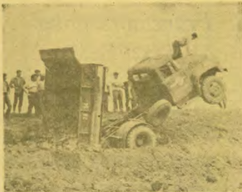
A billenőplátos ZIL-ből nem eszszott ki a föld. A súlypont eltolódott, a gépkocsi eleje a magasba emelkedett. A teherkocsi elejét lánctalpas traktor húzta vissza ismét a földre. A védelmi munkáknál gyakran előfordul ilyen eset, mint a képen látható dobozi Kis Gáborral.
