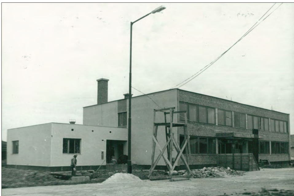
A Fokközi ÁMO-telep építése, 1977.
