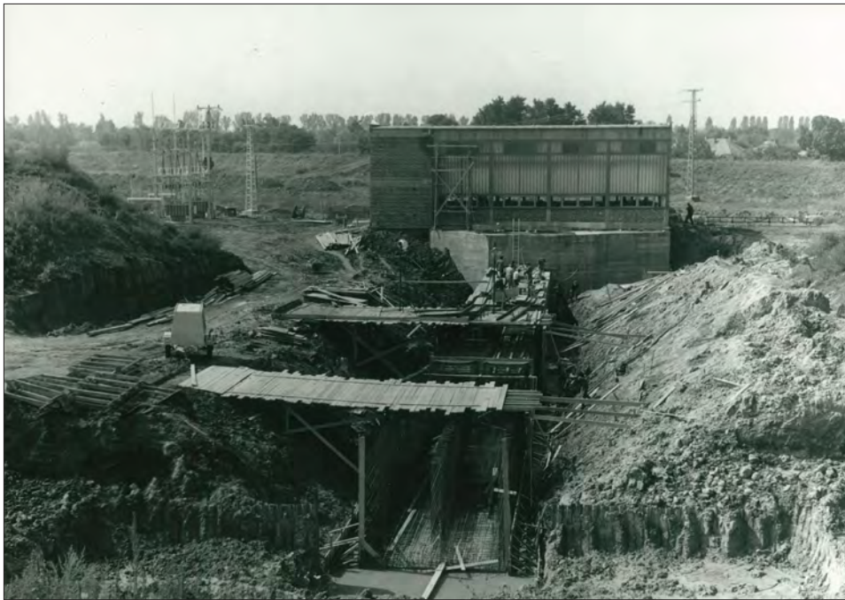
A Békés III. szivattyútelep építése, 1978.
