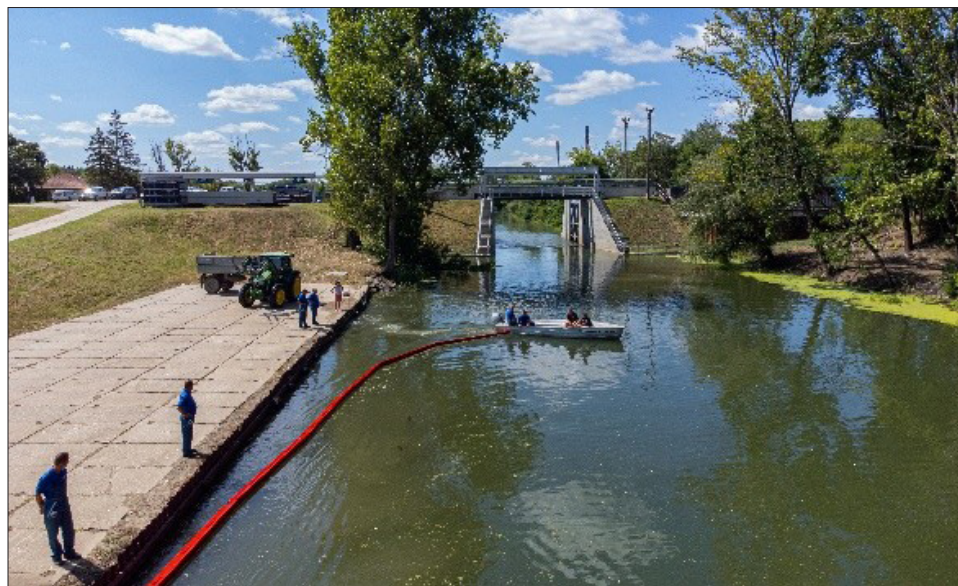
Uszadékterelő fal telepítése
