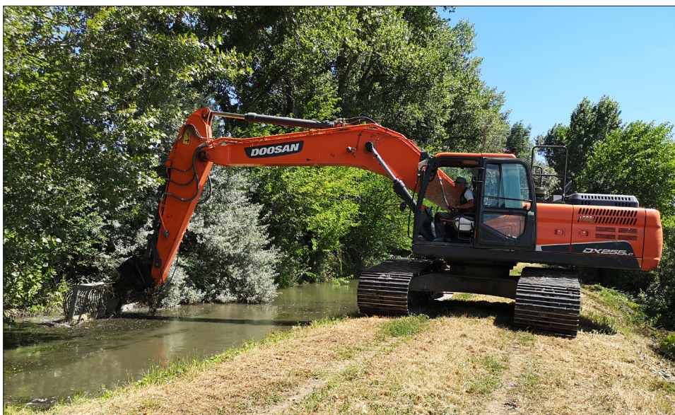
Csatornaszelvények tisztítása
