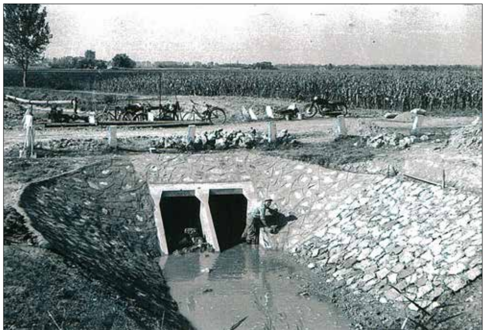
Gyula-Kispél-Eleki csatorna műtárgy építés és kőburkolat készítés (1961.)
