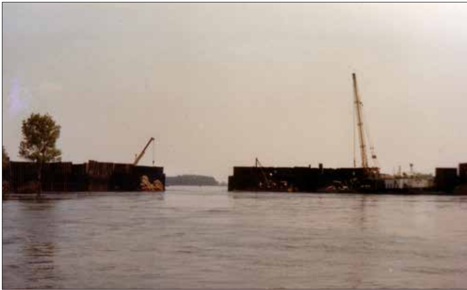
Készül a Kettős-Körös jobbparti töltésszakadás ideiglenes elzárása 1980 augusztusában
