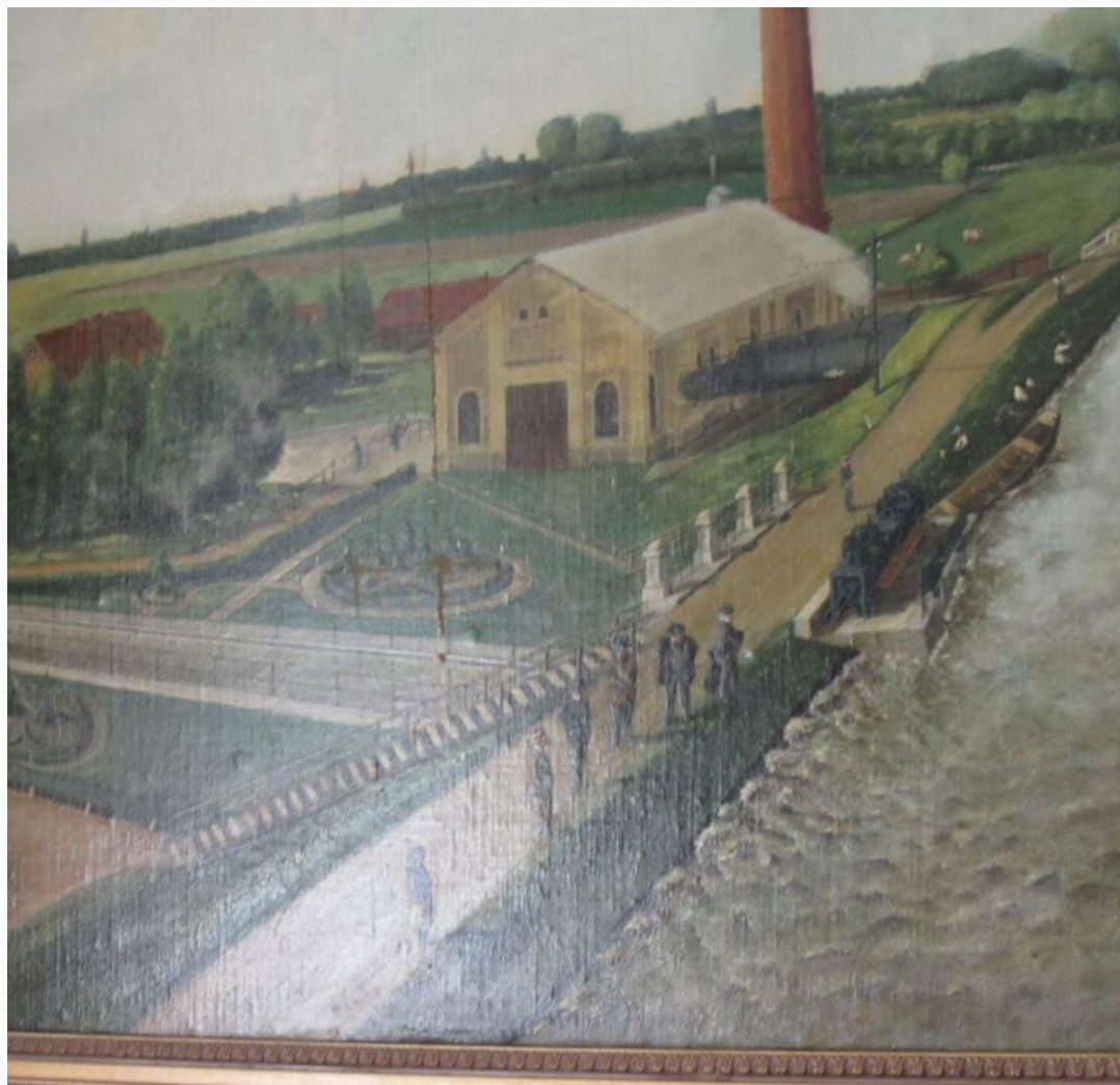
Tiszabercel, gőzüzemű szivattyútelep
