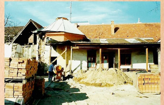
A Pálffy utcai szárny felújítása az udvar felől
