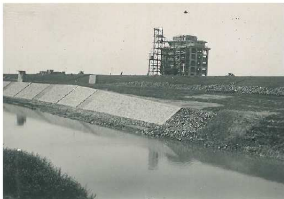
a békési gabonatároló építése
