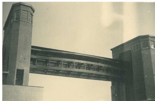
az épülő békésszentandrási duzzasztómű
