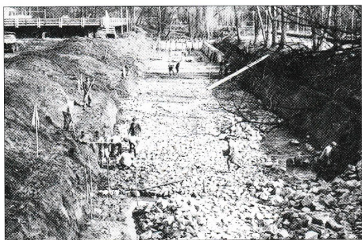
Támfal építése az Élővíz-csatornán Gyulán, 1975
