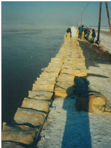
A Fehér-Körös jobb partján nyúlgát építés
