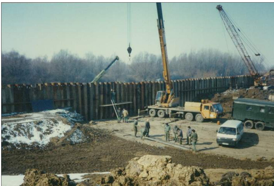
Az ideiglenes elzárás helyreállítása és megerősítése a Mérgesi árvízi szükségtározónál a víz visszavonulása után
