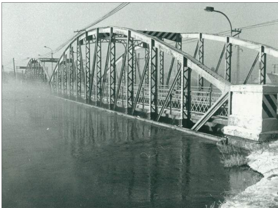
A gőzölgő víztömeg a Gyulavári közúti hídnál
