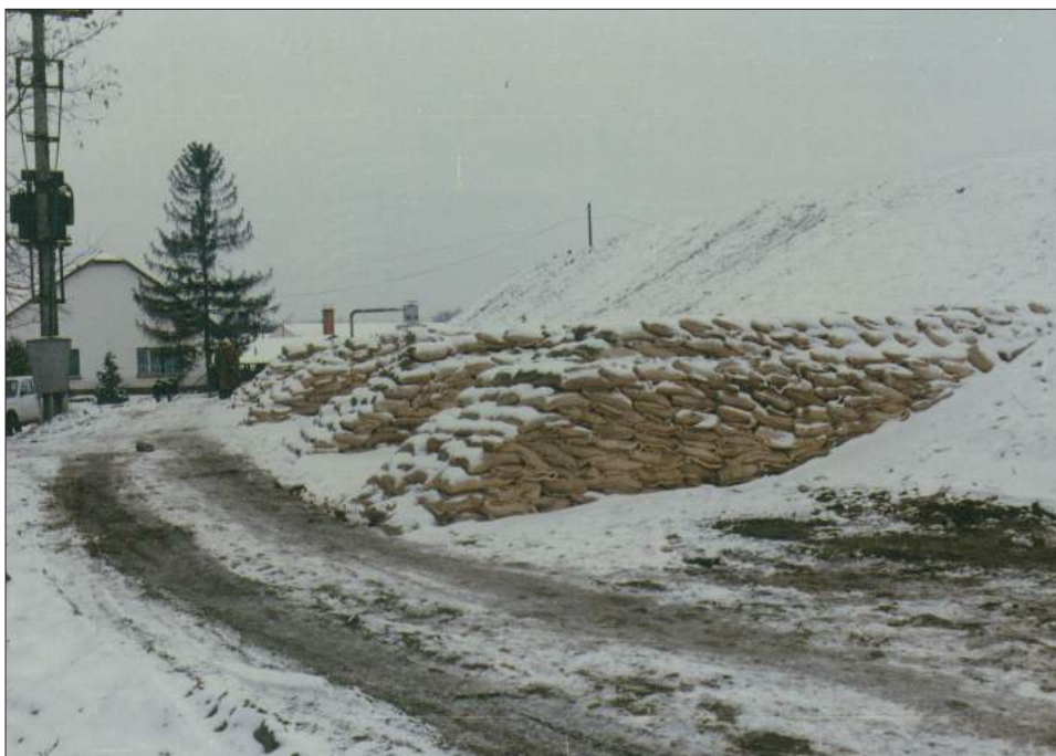
Bordás megtámasztás az I. sz. szivattyútelep mellett
